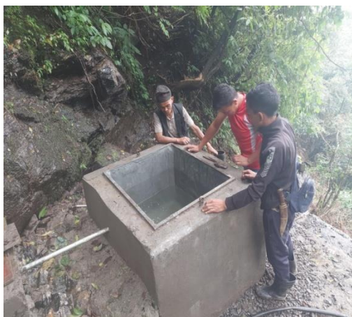
वडा नं ४ अवस्थित भालुखोप खानेपानी निर्माण
